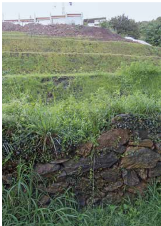
Il muro a secco sostiene il pendio ma lascia scorrere l'acqua. Questa sua capacità gli permette di resistere e svolgere la sua funzione per anni (foto Nicola Petrini)
