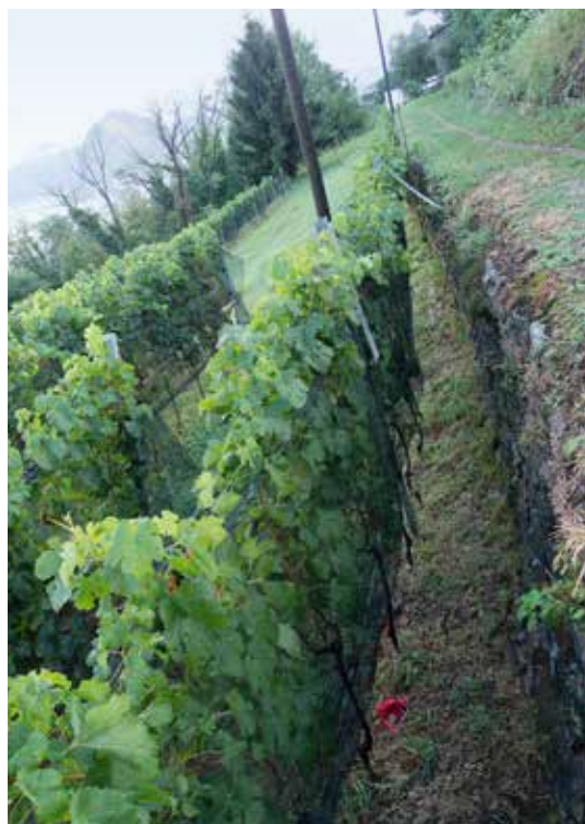
Muro a secco ultracentenario a sostegno di una strada agricola. Se fatto bene un muro a secco può durare secoli (foto Nicola Petrini)
