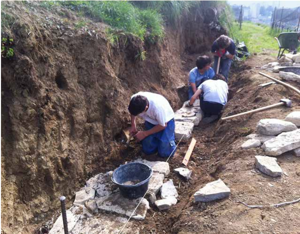
Ragazzi all'opera per costruire il loro muro a secco presso il Centro professionale del verde di Mezzana (foto Nicola Petrini)
